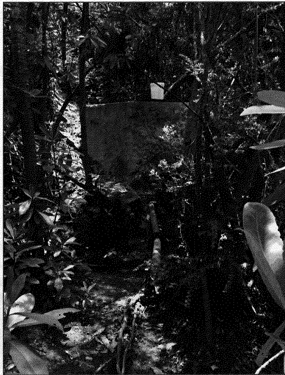
Fotografía 7. Sistema de captación en quebrada dentro del Santuario de la Naturaleza Cerro El Roble (Fotografía: K. Kosiel, 2016).
